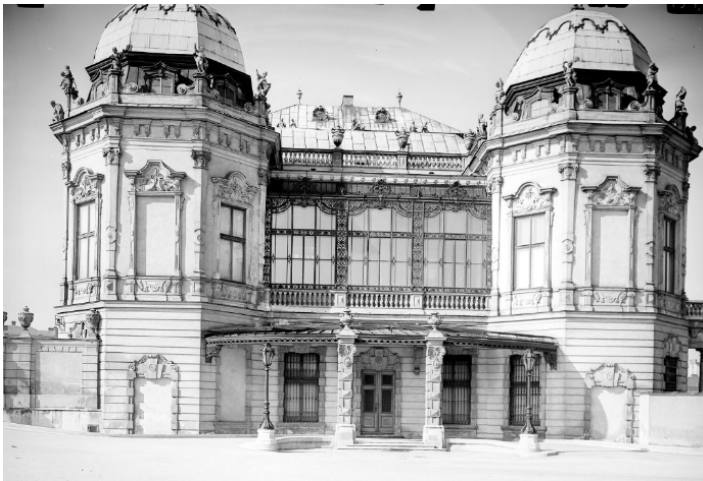
Рис. 3 Верхній Бельведер, частковий вигляд зі східного боку, з оранжереєю та навісом (обидва знесені під час реконструкції), 1938р., Австрійська Національна бібліотека, ВНÖ 1, 62а-С POR MAG
