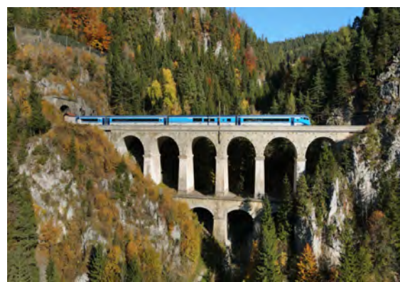
Abb. 5 Semmering-Viadukt, Krausel Klause, Foto C. Stadler-Bwag
