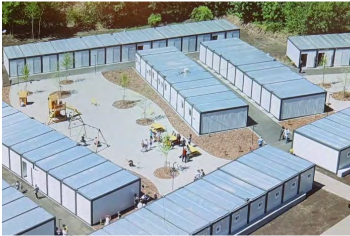
Abb. 5. Containersiedlung für Binnenvertriebene (Flüchtlinge) im Stryiskyi-Park in Lviv. Foto von O. Fenchuk, September 2022.
