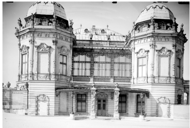
Abb. 3. Oberes Belvedere, Teilansicht der Ostseite, mit Wintergarten und Vordach (beides während der Wiederaufbauarbeiten abgebrochen), 1938, Österreichische Nationalbibliothek, BHÖ 1, 62a-C POR MAG
