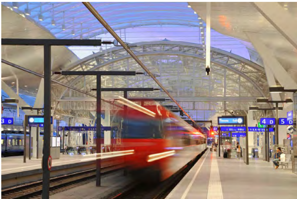
Рис. 8 Зальцбург. Центральний вокзал. Зала з дахом з плівки PTFE Фото: deorito
