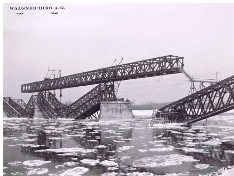
Abb. 2 Wiederaufbau Tullner Donaubrücke 1946, Foto:WaagnerBüro
