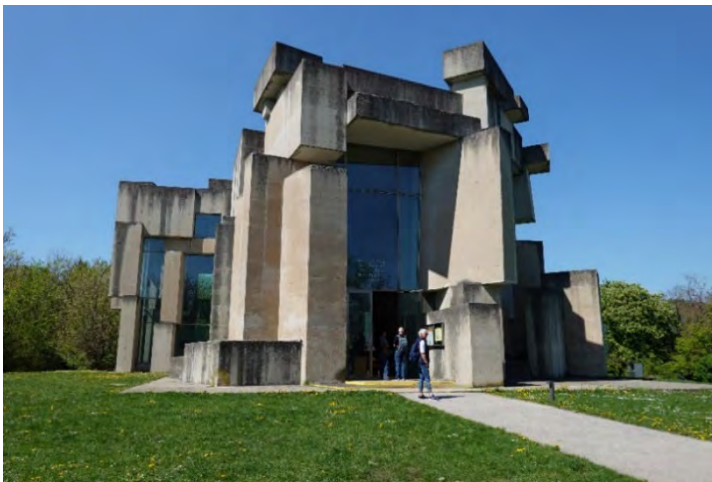
Іл.10, 11. Римо-католицький костел Св. Марії (церква Вотруби), збудований за моделлю скульптора Ф. Вотруби (F.Wotruba) зі 152 бетонних блоків. Арх. Ф. Майер (F.G.Mayr), 1976. Власні фото 2024.
