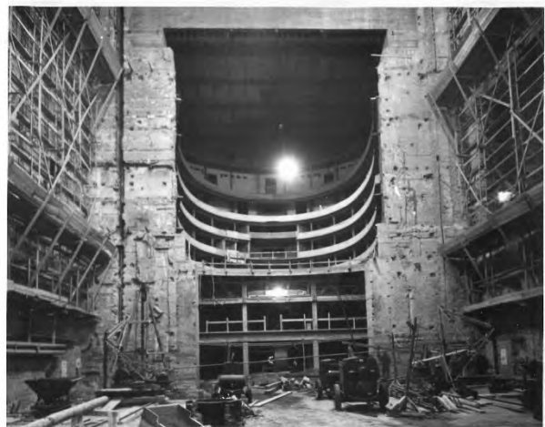
Abb.1. Wiener Staatsoper, Blick von der Bühne in den Zuschauerraum, nach Beginn der Wiederaufbauarbeiten, Aufnahme 1952, BDA-Archiv, Fotoarchiv, N 2971.
