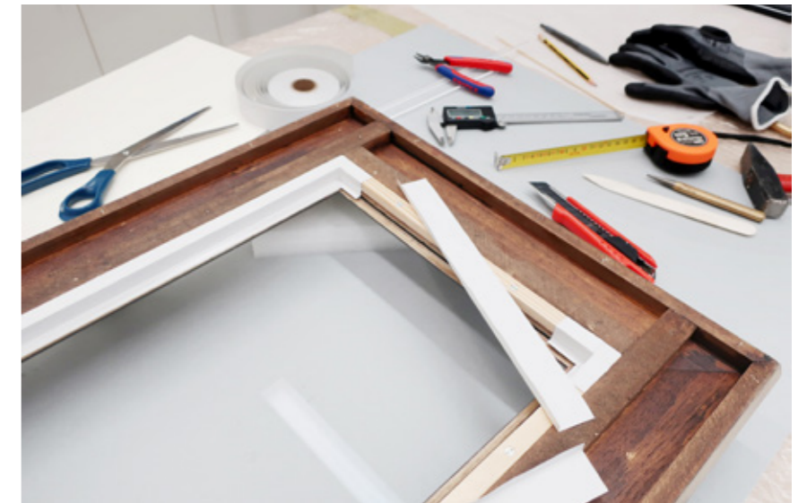
Der Rahmenfals wird bis über den Rand der Glasscheibe dampfdicht versiegelt.
