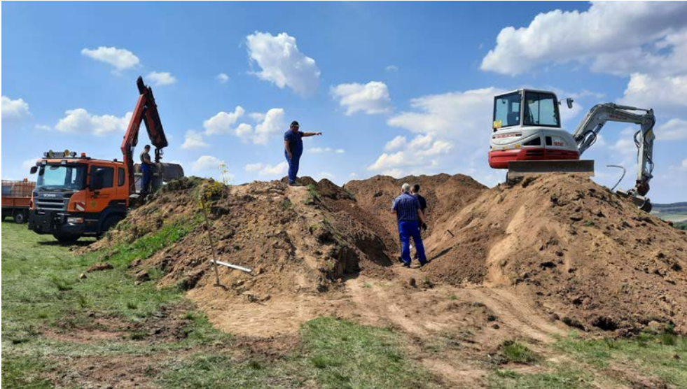
Aufbau, Grabungsarbeiten, Bauhof Mistelbach
