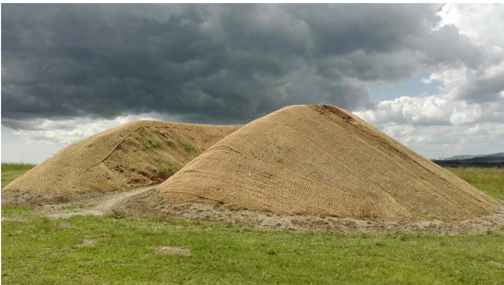
Aufbau, Grabungsarbeiten, Bauhof Mistelbach
