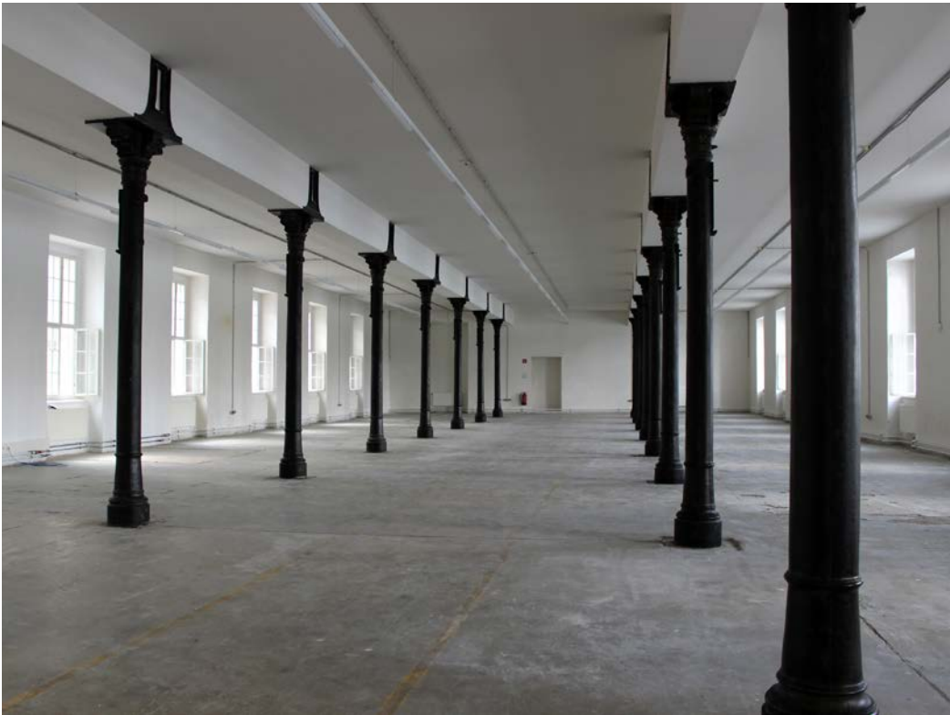
Westsaal geräumt und leer, ohne Gussasphalt
