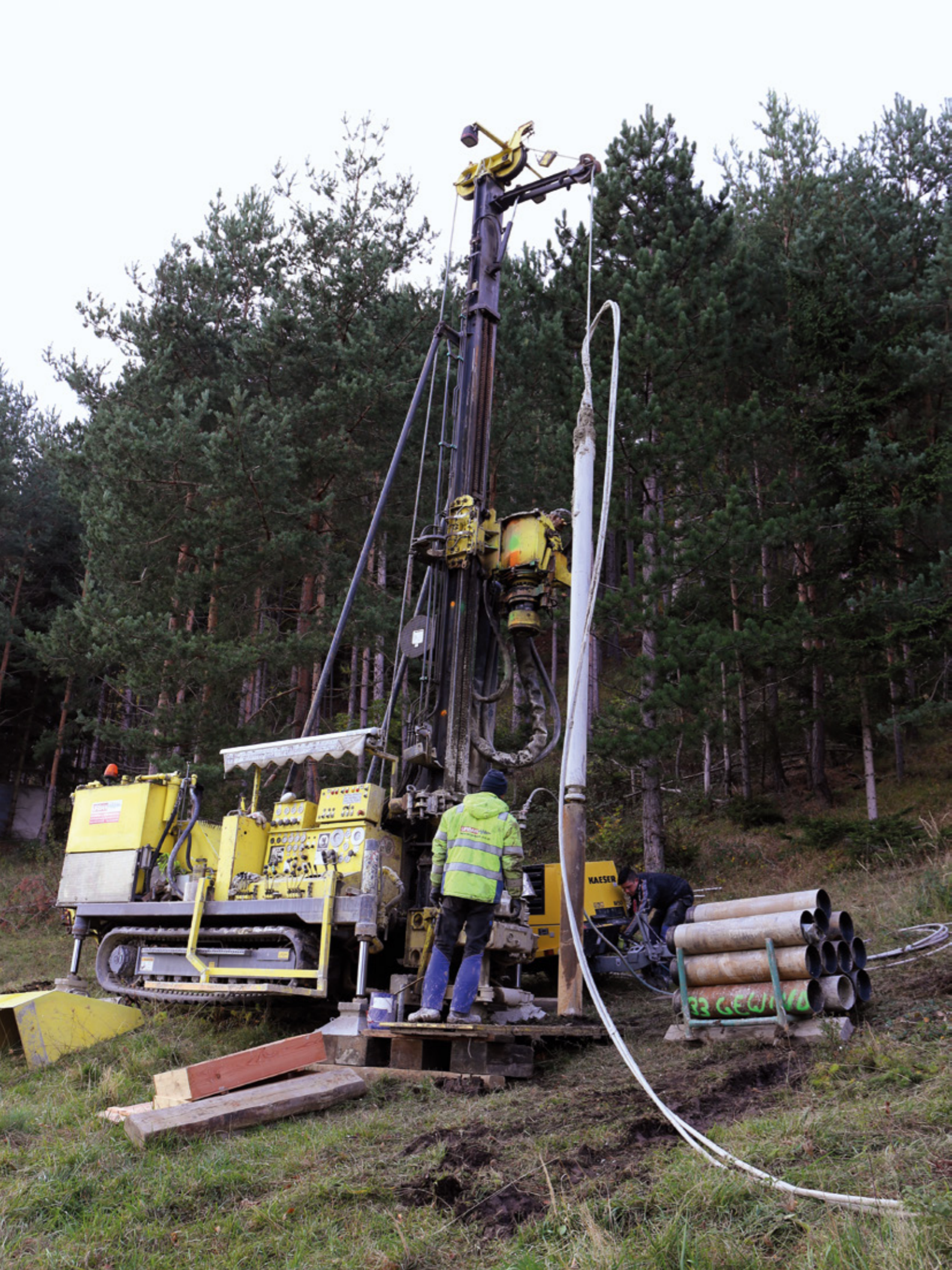
Mit einem Spezialbohrgerät wurden Bohrkerne bis zu einer Tiefe von 37 m gewonnen. (Foto: Peter Trebsche)
